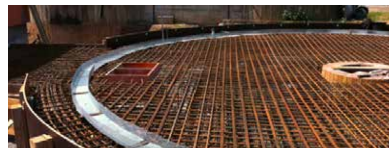
Abschalung im Behälterbau
