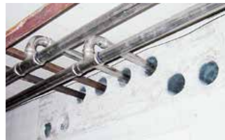
Wand- und Deckendurchbrüche
