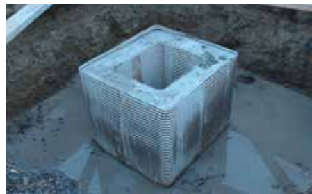
Ausführung als Blockfundament zur Aufnahme von Fertigteilstützen
