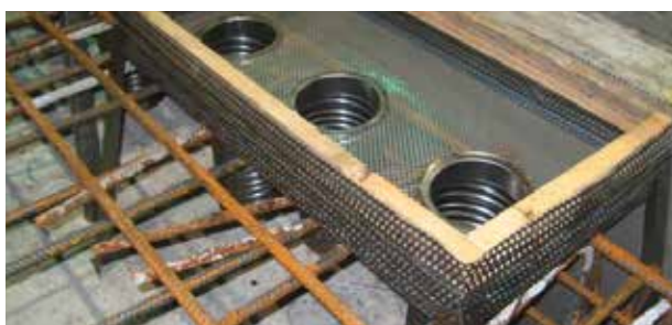
Aussparungen im Maschinenfundament
