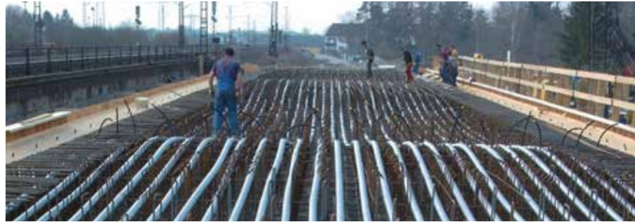
Brückenbau / Spannkanal zur Aufnahme der Spannlitzen
